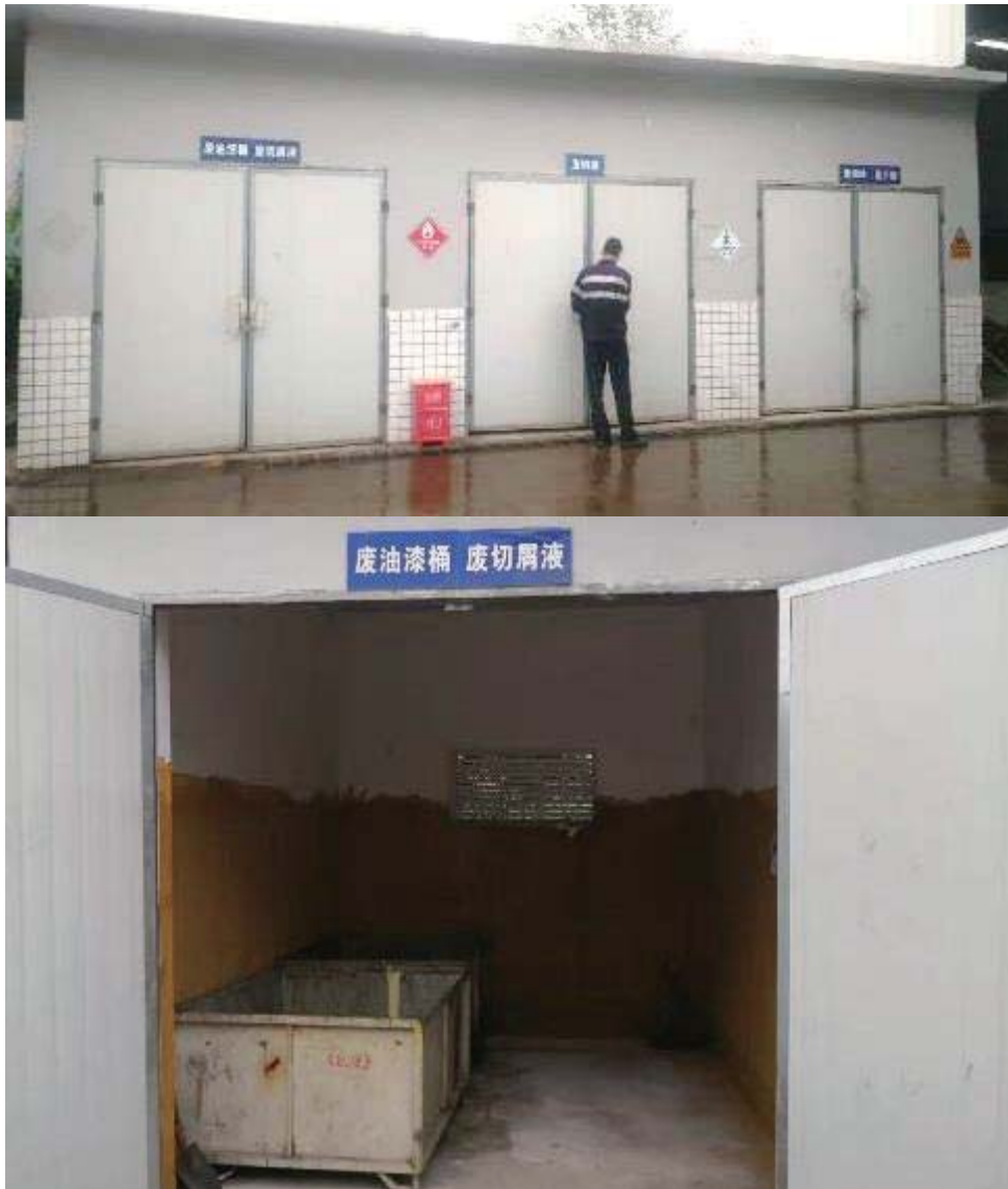
图 3-3 危废暂存间现场照片
