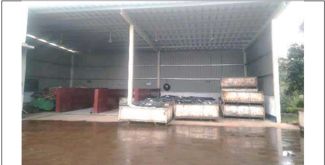
图 3-2 固废暂存间现场照片
