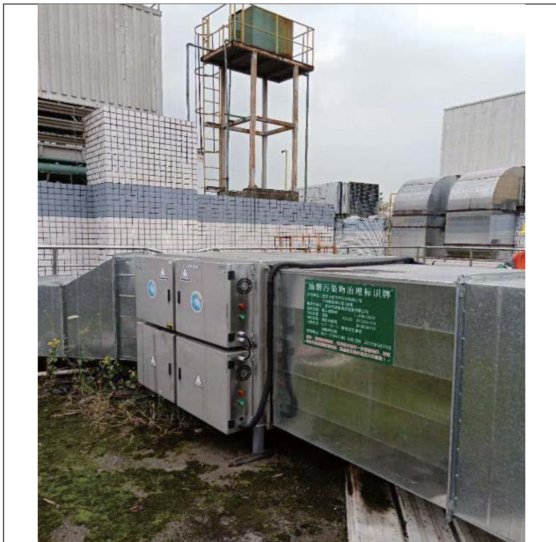
图 3-1 “以新带老” 增设的油烟净化装置
